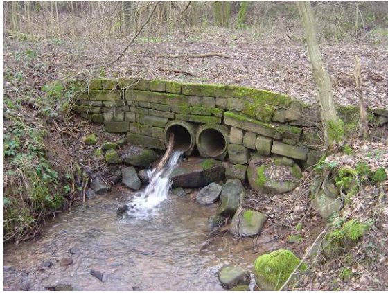
„Lautenbach“ (Werschweiler): Vorher
