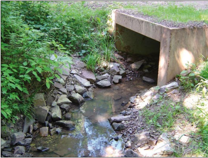
Abb. 7: Durch den Einbau von Kastenprofilen mit offener Sohle anstelle der Verrohrung wird die biologische und sedimentologische Durchgängigkeit des Gewässers wieder hergestellt.
